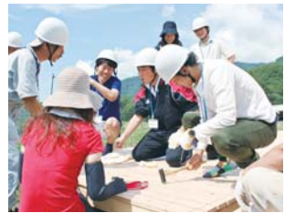
間伐材や林地残材を用いた休憩小屋の作成②
